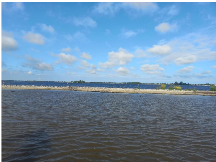
Figuur 3 Impressie van de Nieuwe dam vanaf het werkschip
